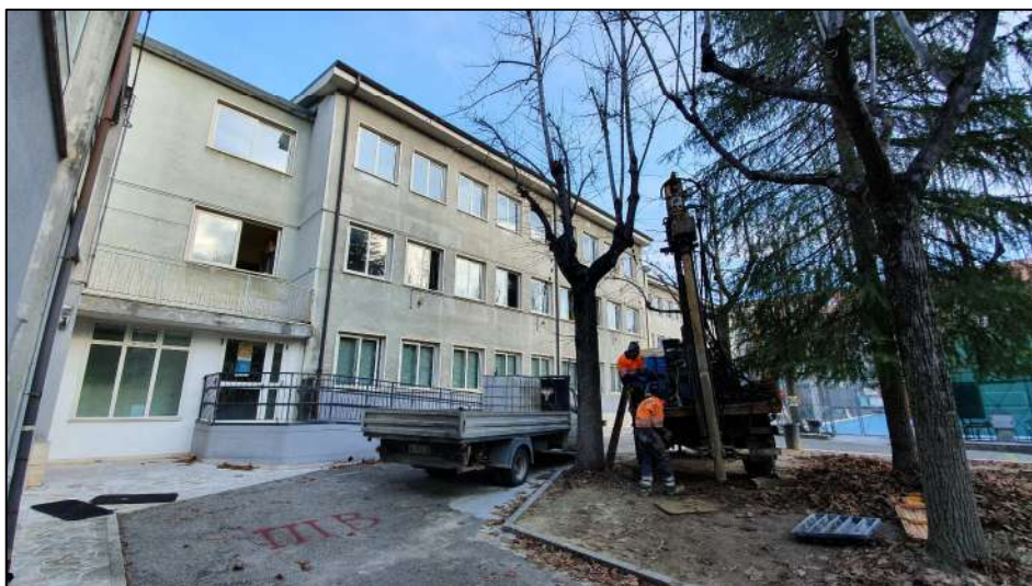
Foto 1: La foto presa da Sud-Ovest mostra la sonda durante l'esecuzione del sondaggio geognostico S1
